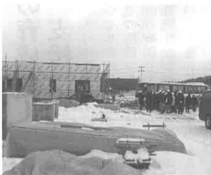
▲ ガス水道局 LNGサテライト基地建設現場視察の様子
