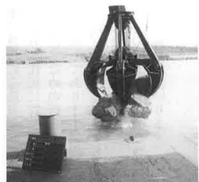
▲ 築いそ工事のようす
