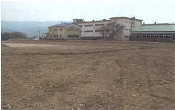
造成された仁賀保総合中学校の建設用地
