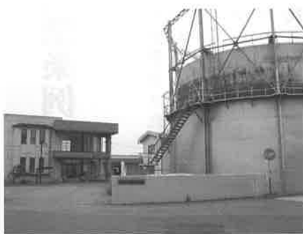
ガス水道局 (右側:有水ホルダー)
