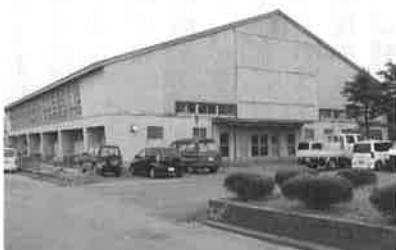
旧象潟中学校体育館
