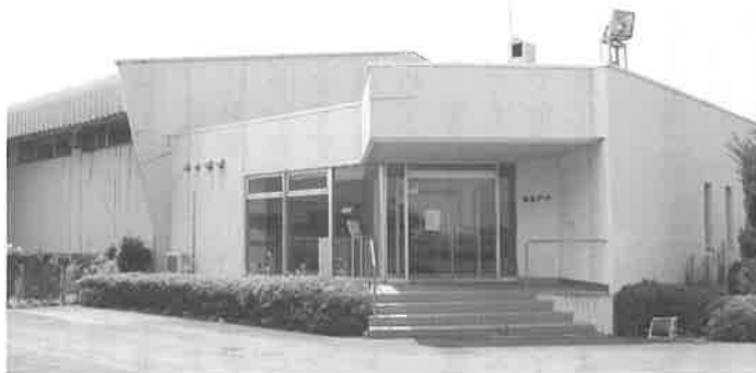
▶金浦地区TDKプール
