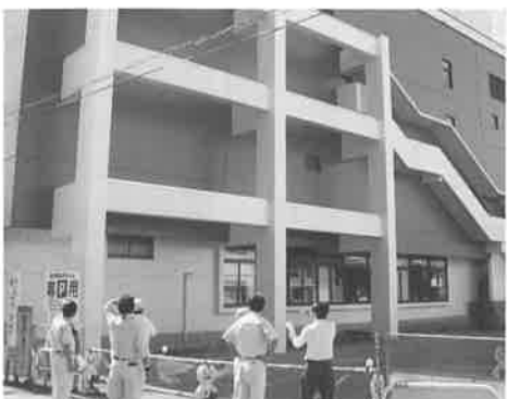
▲「仁賀保勤労青少年ホーム耐震化工事」視察
