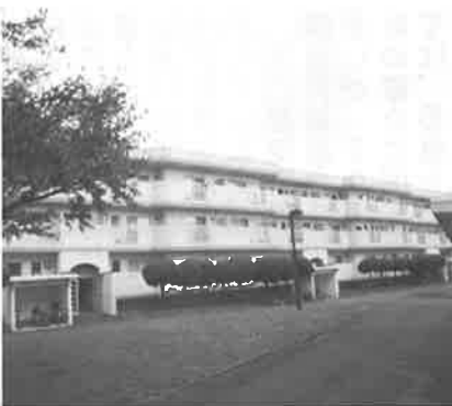
▲写真は「市営住宅さくら」
