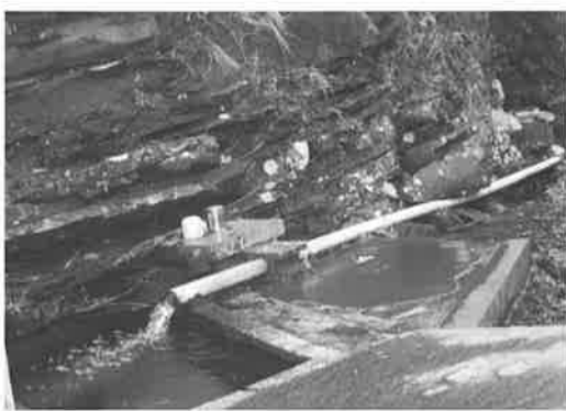
▲上浜簡易水道(小砂川地区)の清水場水源(湧水)
