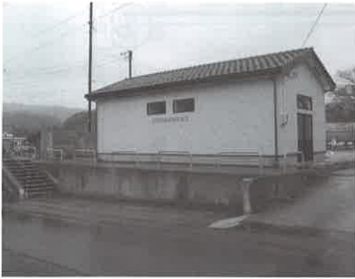
▲仁賀保地区防災倉庫
