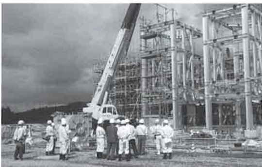
▲ 現場踏査（熱回収施設）
