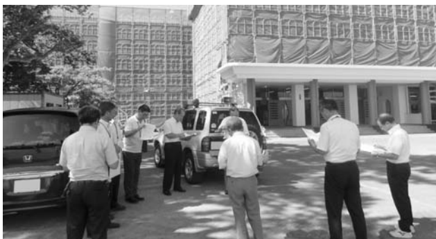
▲象潟小学校大規模改修工事 現場踏査
