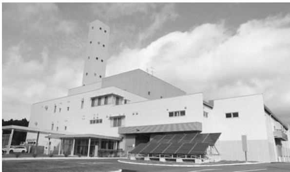
▲ 順調に稼働している環境プラザ
