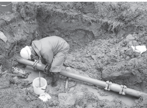
漏水復旧工事の様子
