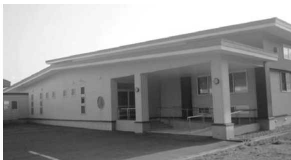
▲天井張替え改修をした金浦武道場
