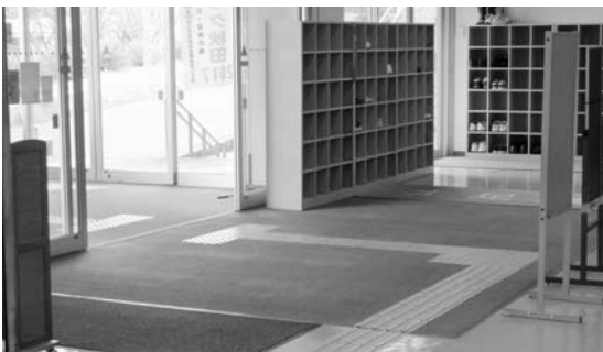
▲ 段差のない玄関(象潟体育館)
