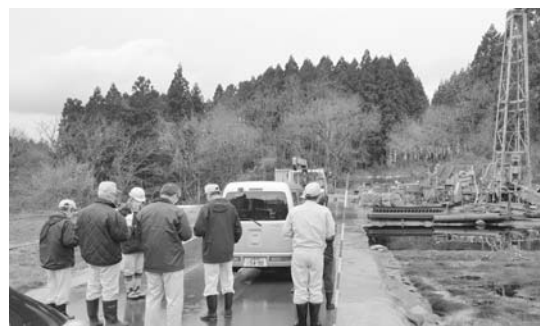
▲桂坂廃止石油坑井封鎖の現場
