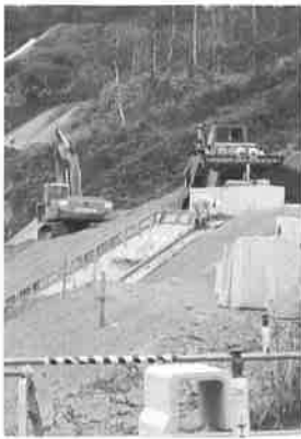
▶ 高速道路工事現場(仁賀保)
