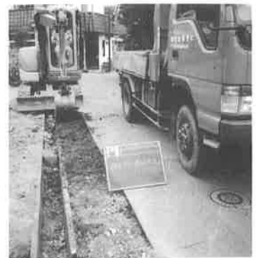
▲ 地区要望の工事現場のようす
