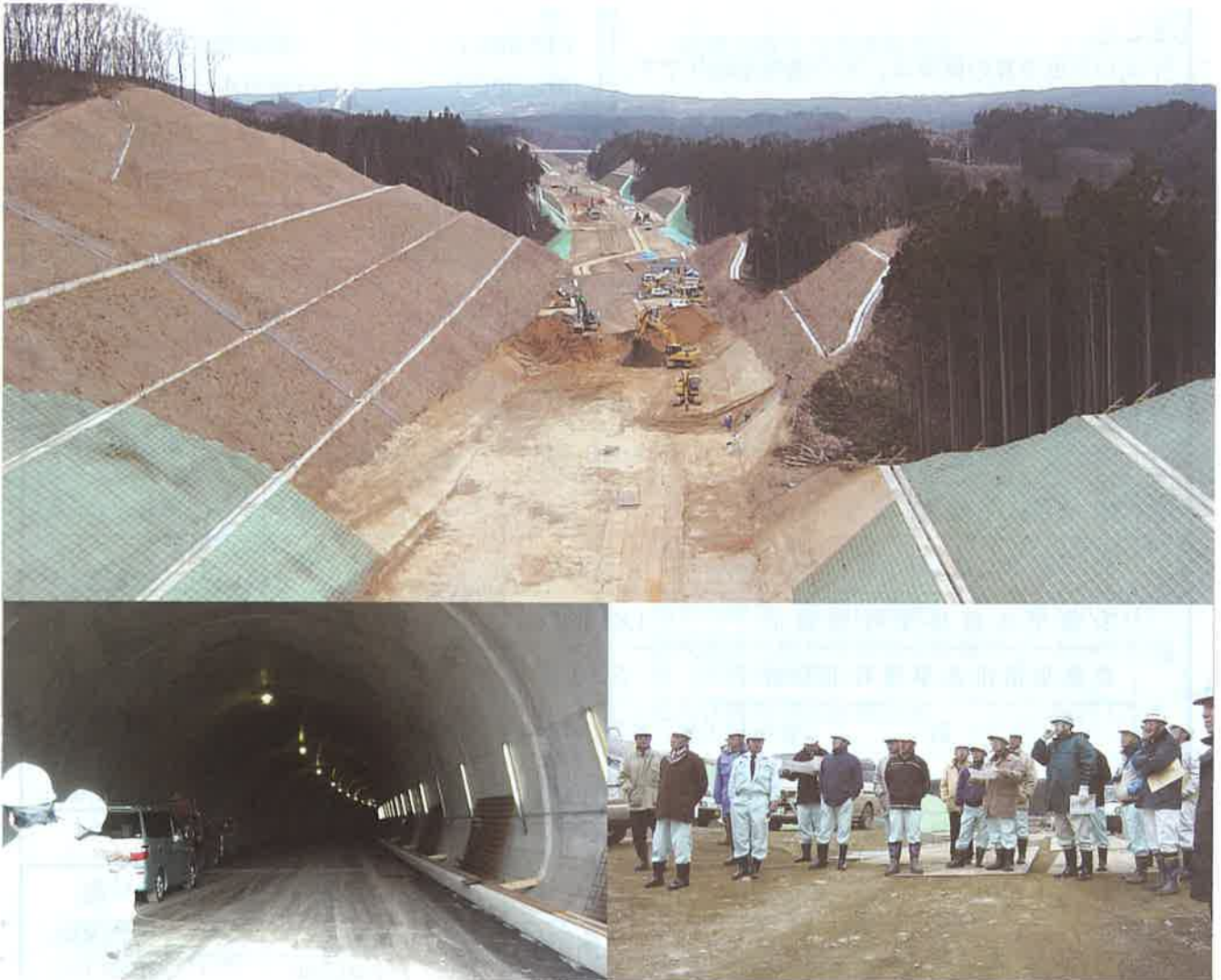
2月19日、日沿道工事現場視察のようす
