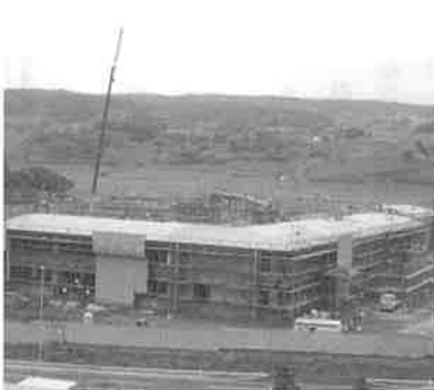
▲ 建設中の象潟中学校新校舎
