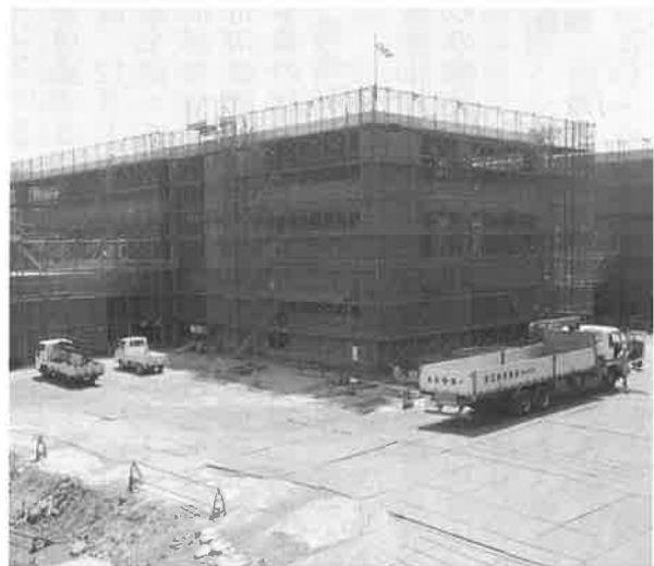
▲ 建設中の仁賀保統合中学校
