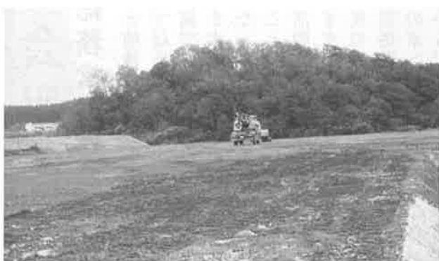
▲ 広域介護老人福祉施設建設予定地
