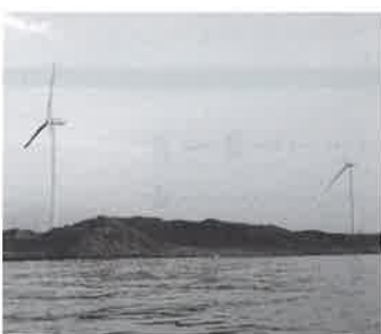
▲飛地区にある風車2基
