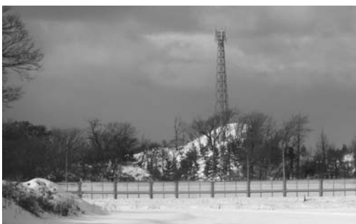
▲ 携帯電話基地局（鉄塔タイプ）
