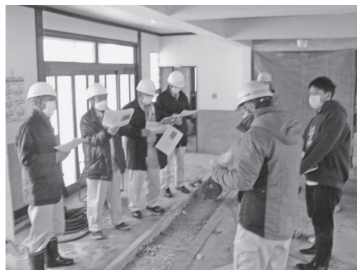
改修工事現場踏査(横岡)
