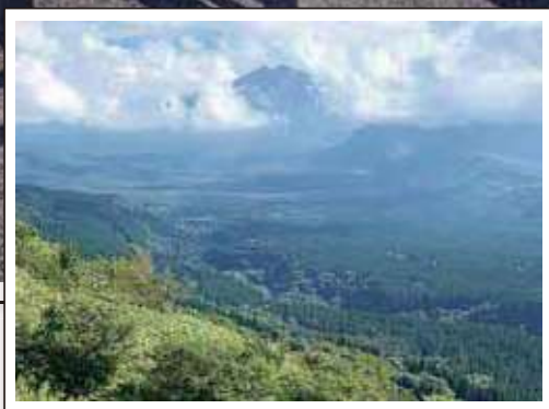
▲山体崩壊の跡
