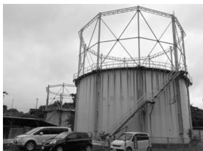
▲ 譲渡されるガス事業施設
